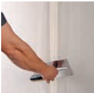
Stažení výztužné pásky hladítkem, poté nechte tmel vytvrdnout
