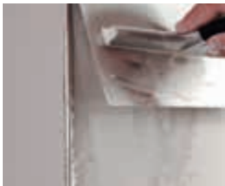
Výztužná páska (alternativně) zatmelená po obou stranách
