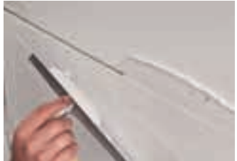
V první etapě tmelení příčných spár se tmel nanáší kolmo ke spáře
