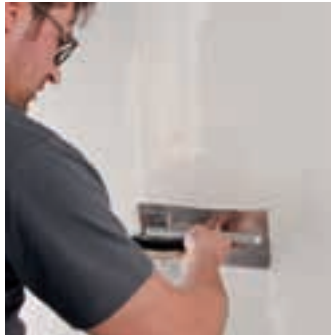
Případná třetí etapa tmelení s roztažením do šířky
