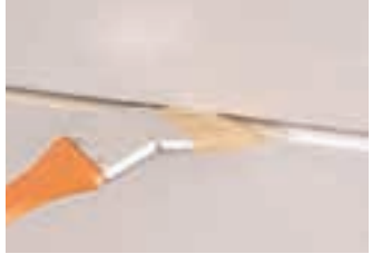
Vyčištění příčných spár
