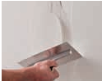
Vyplňování podélné spáry kolmo ke spáře
