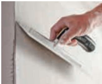
Roztažení tmelu v rohu do šířky
