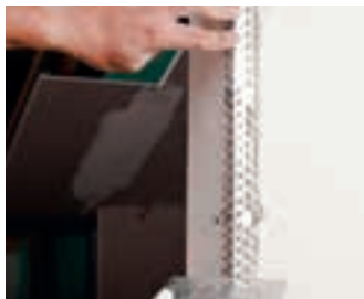
Rohový profil zatlačíme do tmelu
