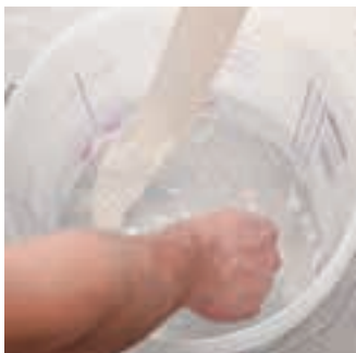
Navlhčení papírové výztužné pásky
