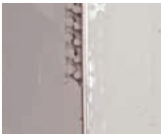
Po první etapě tmelení stáhneme tmel
