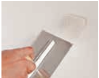
Zatmelení hlav šroubů v horní vrstvě opláštění
