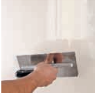
Druhá vrstva tmelu přes výztužnou pásku
