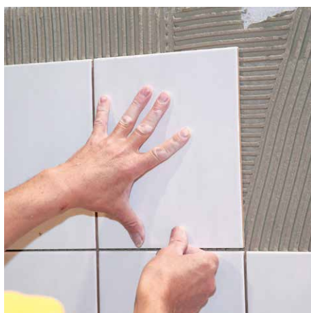
Stěny Ytong můžeme přímo obkládat.
