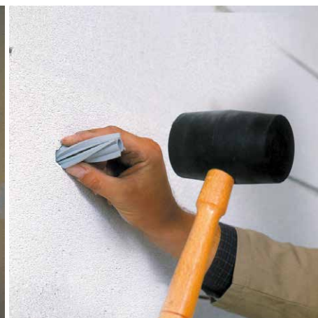
Hmoždinky určené do pórobetonu zaručí spolehlivé kotvení.
