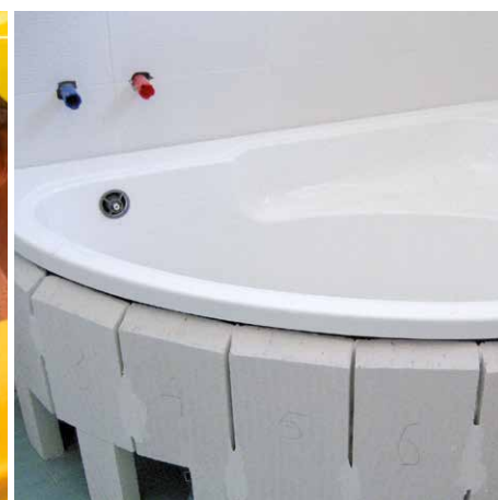
Podezdění vany s materiálem Ytong je bezproblémová záležitost.
