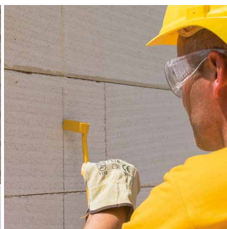
Vytváření drážek pomocí drážkovače představuje jednoduchý úkon.
